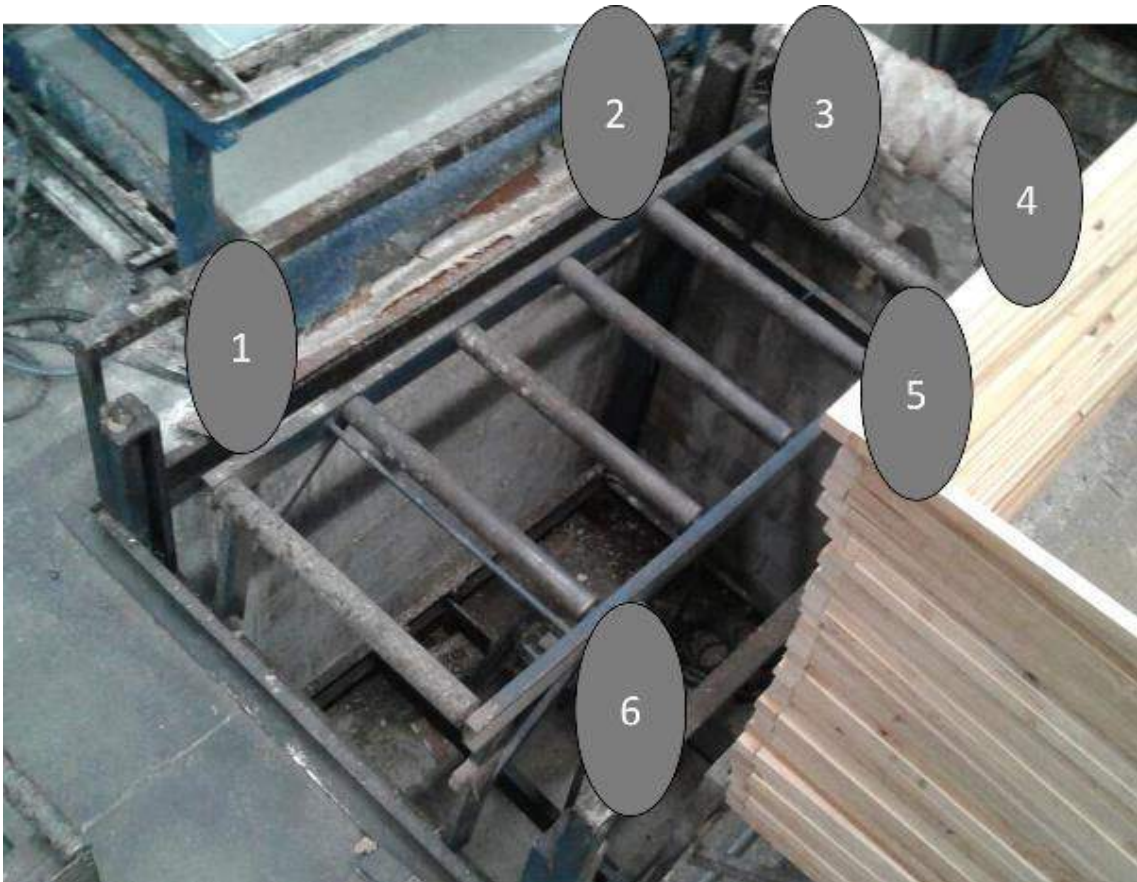
Foto 1. Pontos de Instalação das guias no subprocesso Montagem
